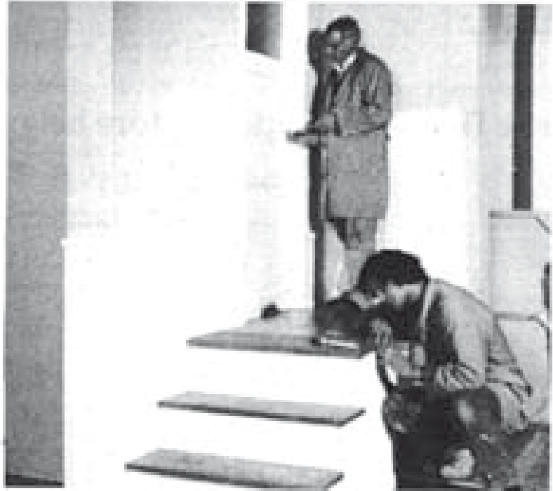
La costruzione di uno stand per salotti
